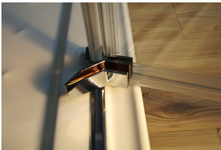
Spodní hranu dveří osadit těsněním a plasty. Plastové díly nasadit na těsnění a poté nasu- nout na sklo
