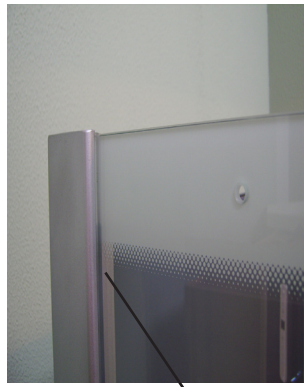
Utěsnit těsněním seal
