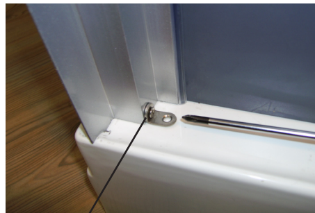
Použít šrouby 4,2x12 Svislé profily spojit s vaničkou use screws 4,2x12, link the vertical profiles with shower tray
