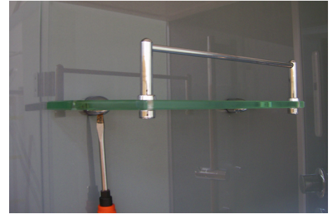
Instalovat policičku na boční díl install the shelf on the side panel
