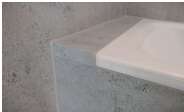
15. TECHNIKA OHÝBÁNÍ V-SPÁRY
